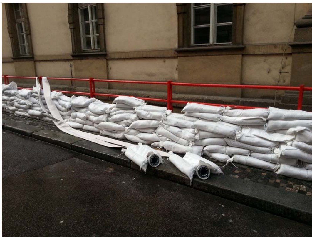
Povodňová zábrana a hadice centrálního čerpadla u Klementina v Platněřské ul.
