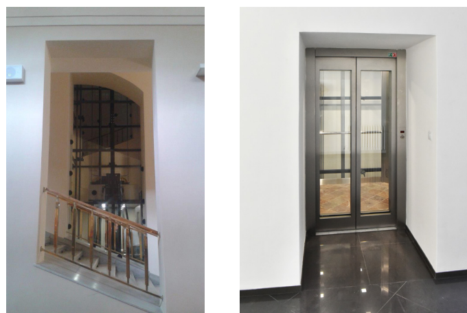
Vestavba moderního výtahu v Klementinu
