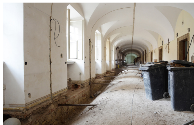
Táhla v podlaze budovy Klementina
