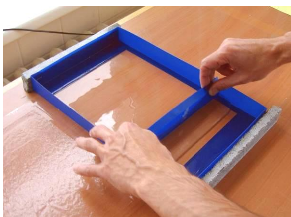
Obr. 13 /Nanesení lepidla plastovým rámečkem, stažení lepidla pomocí rovné stěrky.
