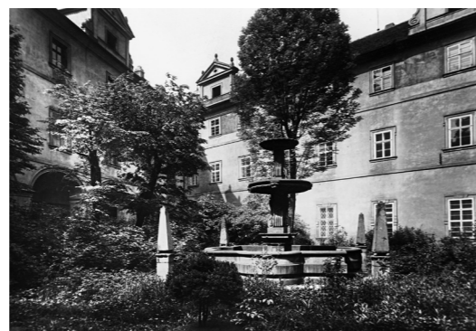
Révové nádvoří před zahájením přestavby
